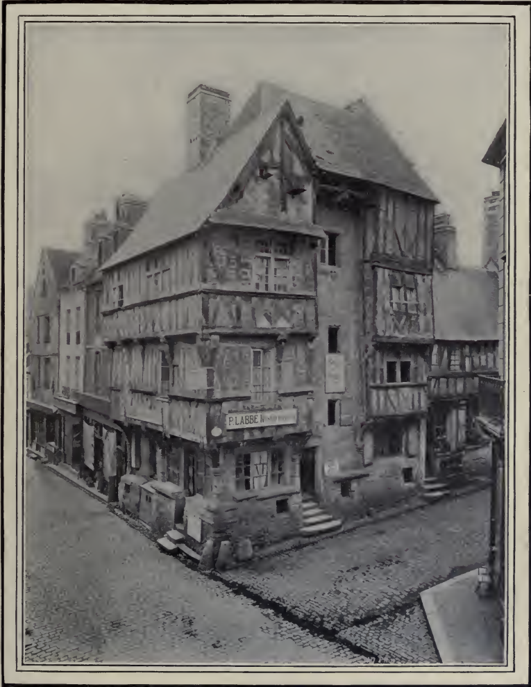
FIG. 10.—WOODEN HOUSE IN PARIS (AUBE).
