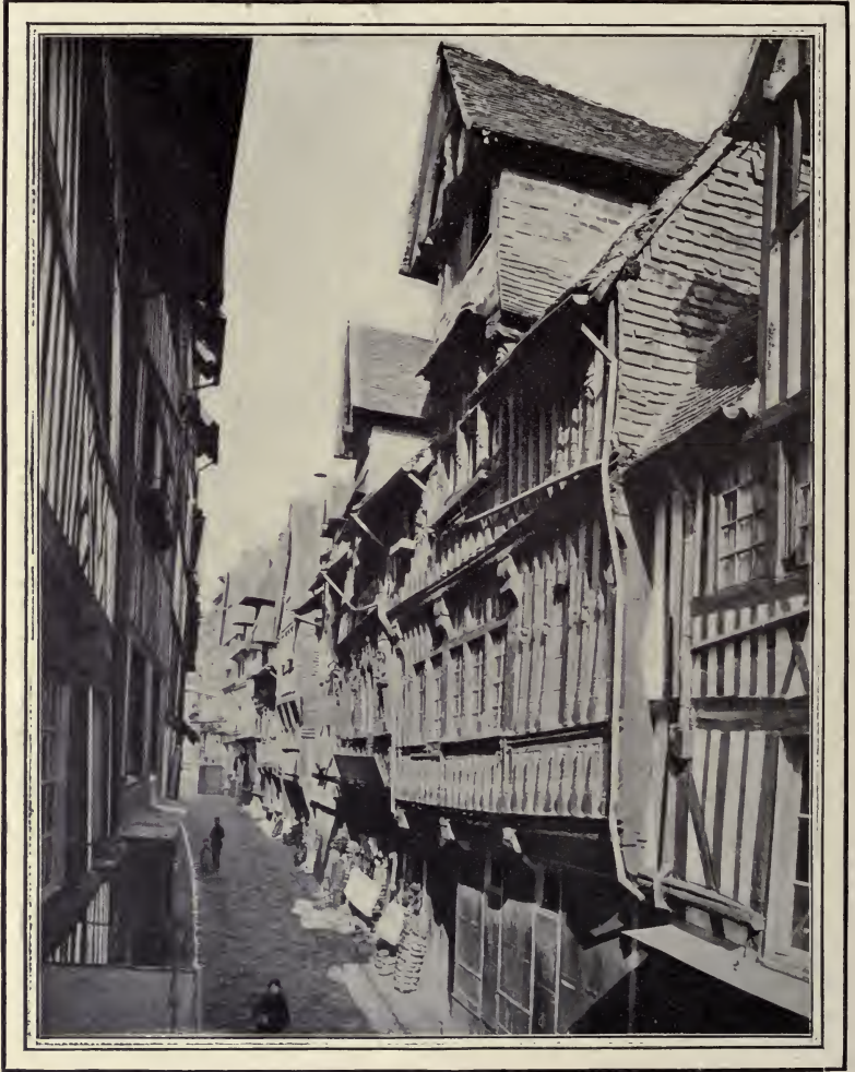
FIG. 9.—RUE AUX FEVES, LISIEUX. (Houses of the XVIIth Century.)
